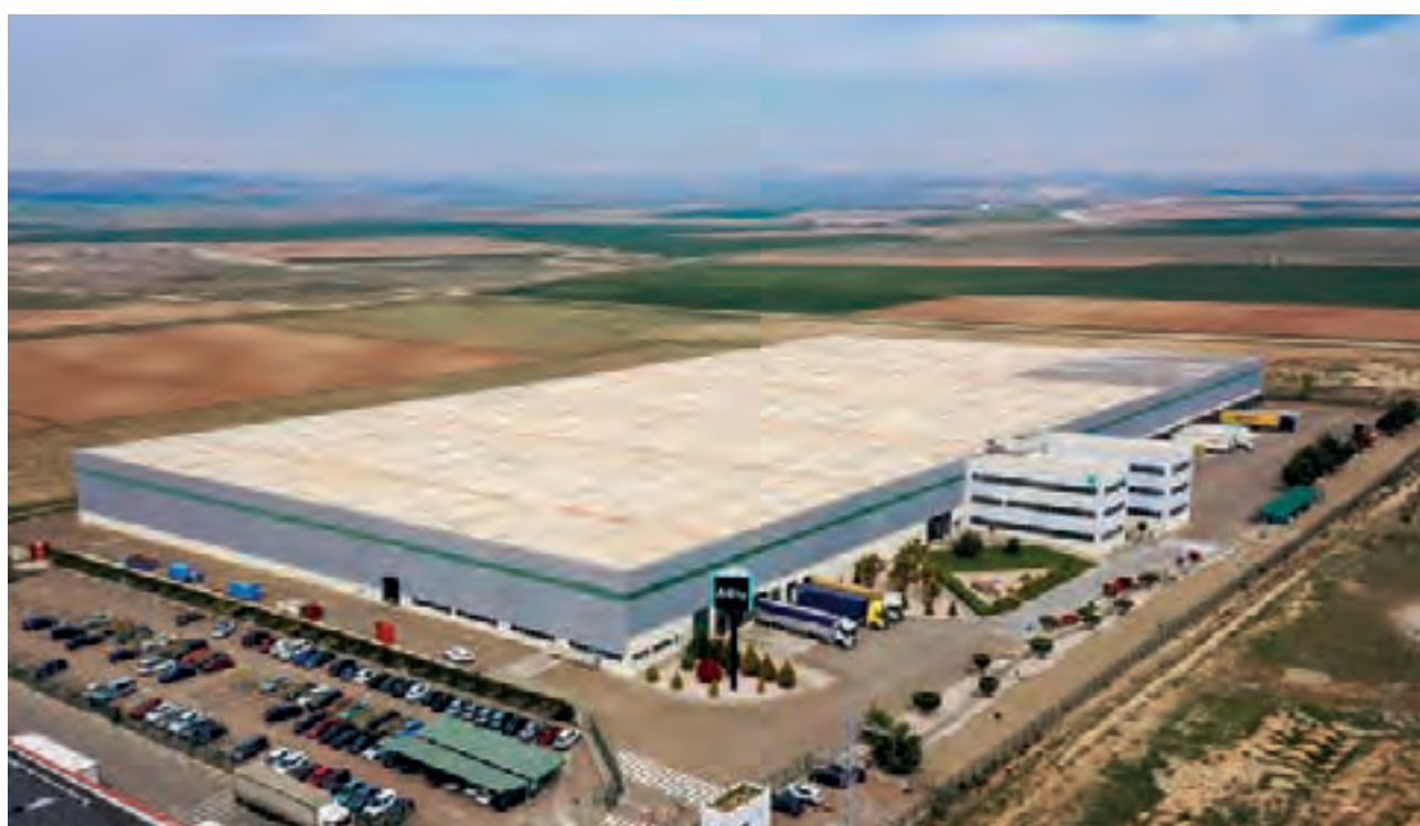
Vista aérea de las instalaciones en Zaragoza (España). Precios válidos salvo error tipográfico, fotográfico o fin de existencias.
